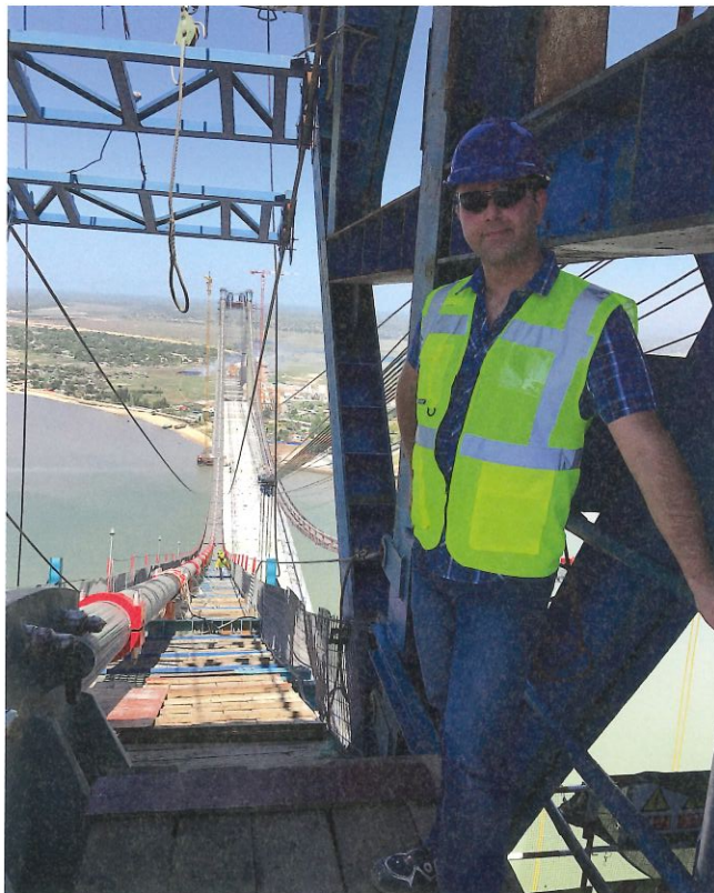
Schweiß- und Prüfaufsicht in Maputo, Mosambik – längste Hängebrücke Afrikas
