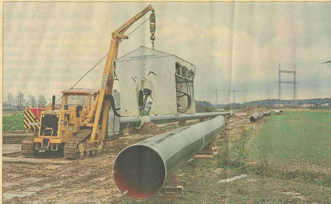
Spektakulärstes Projekt der Metal Check GmbH in der Region ist die Prüfung der Rohre für die Erdgas Pipeline Monaco. – Foto: ede
