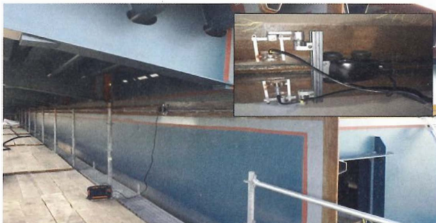
Bild 8 „Beispiel einer TOFD Anwendung im Brückenbau“ ©Metal Check
